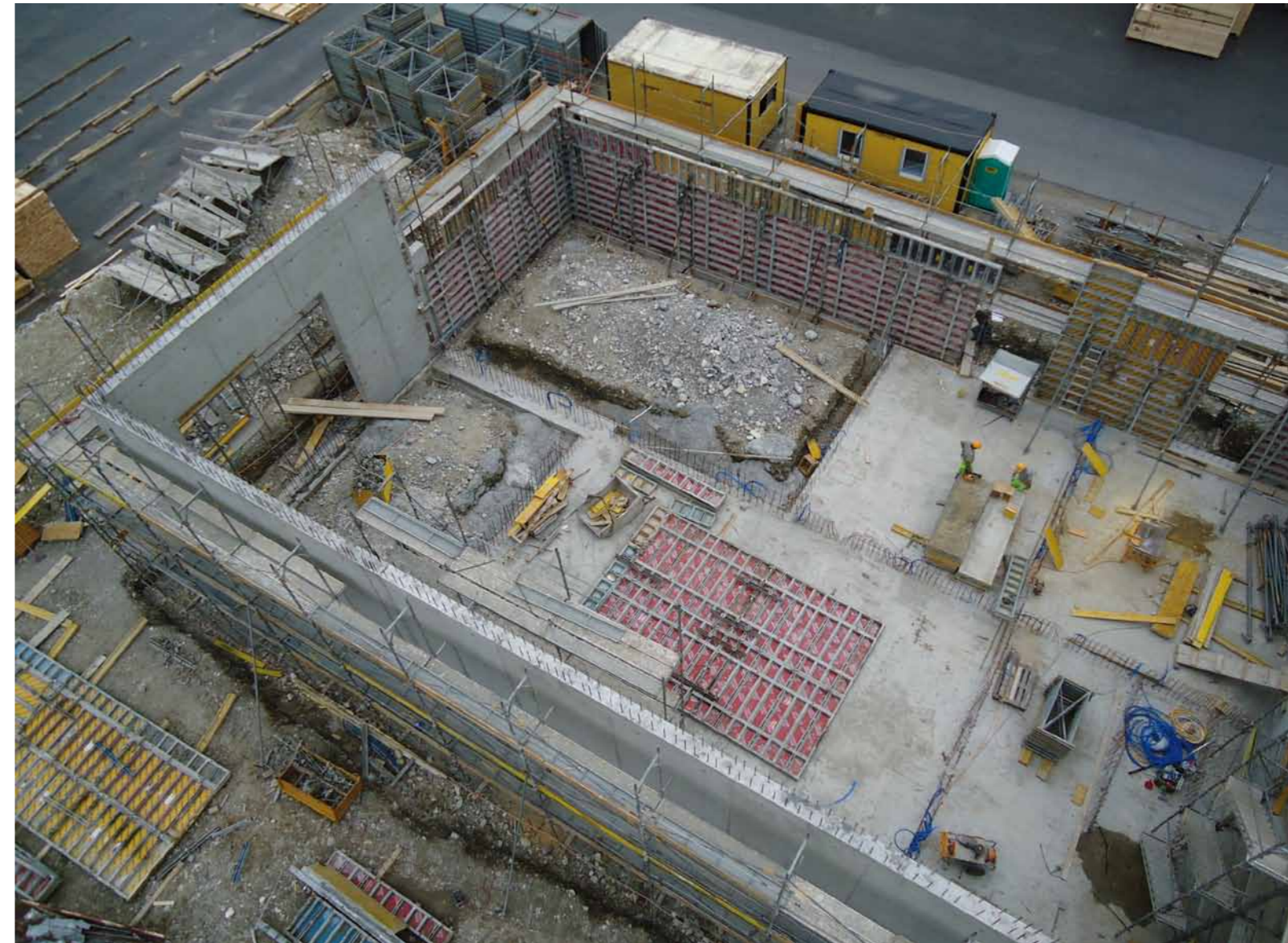
Der Rohbau des Unterwerks wurde durch die Bauunternehmung Lazzarini AG erstellt. Es wurden 1'050 m 3 , resp. 2'600 Tonnen Beton mit über 4'000 m 2 Schalung und 80 km Bewehrungsseisen verbaut.
