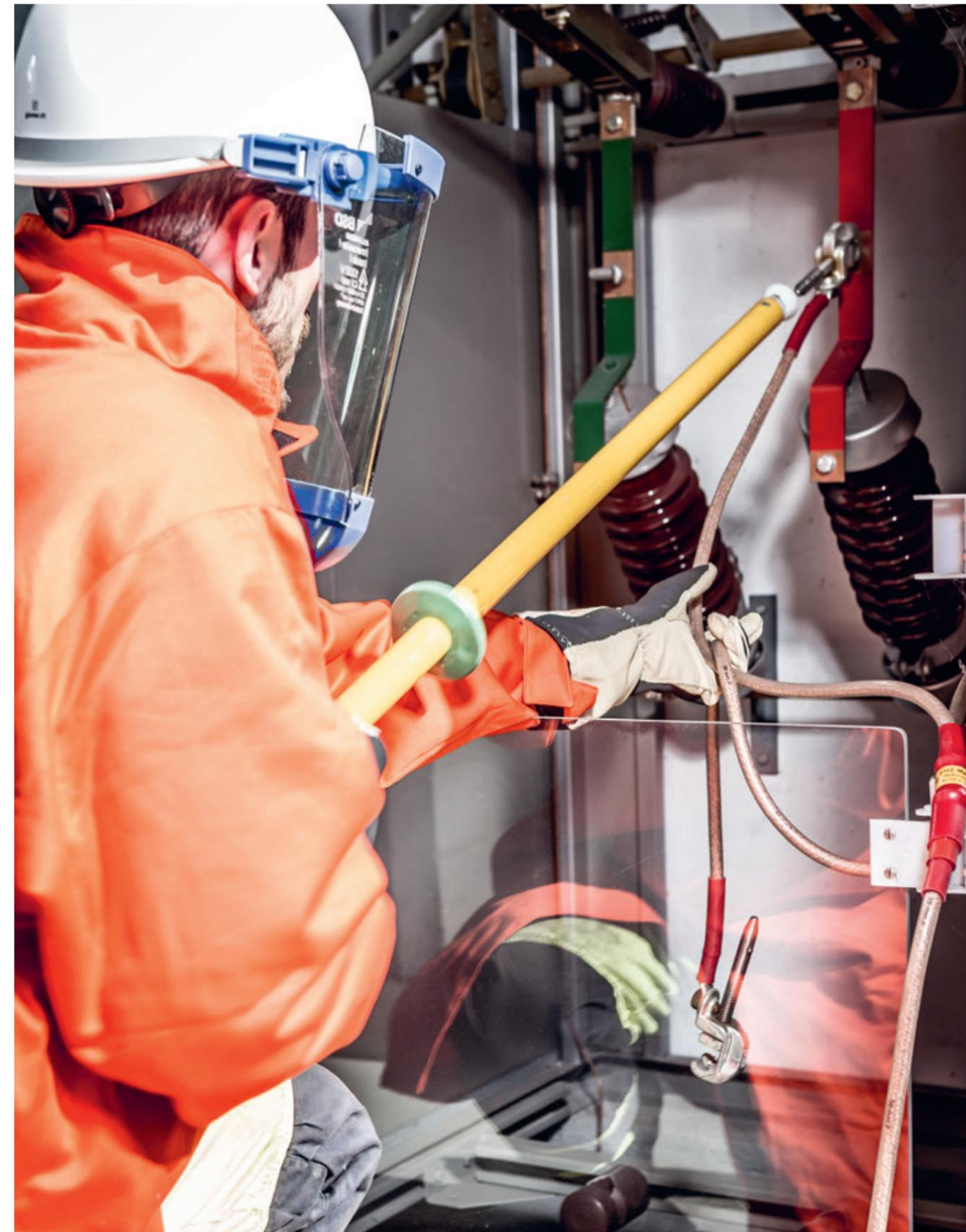
Netzelektriker Ivo Luzzi schliesst die Erdungsgarnitur an einer offenen Mittelspannungsanlage an.
