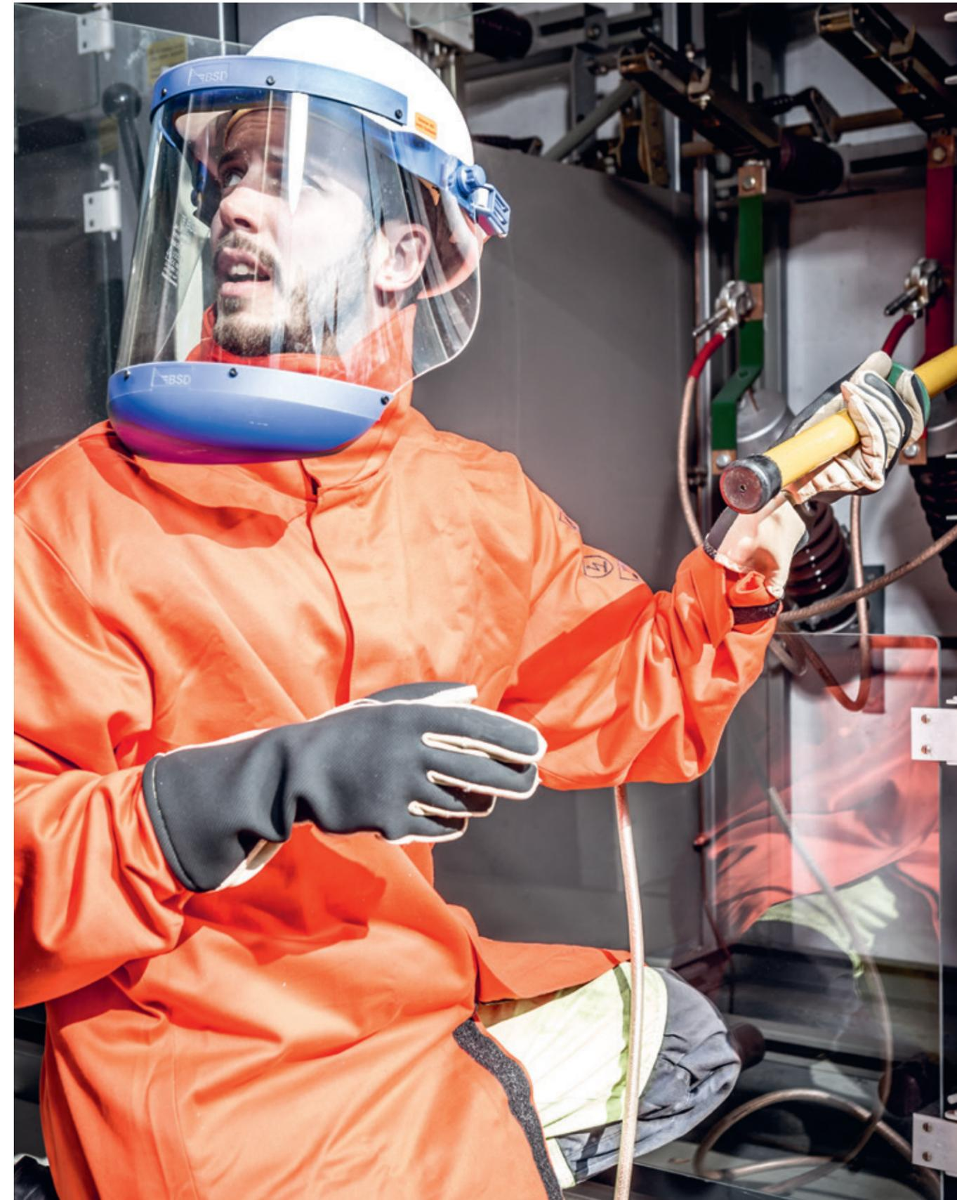
Netzelektriker Ivo Luzzi mit persönlicher Schutzausrüstung bei der Ausführung eines Schaltprogrammes.
