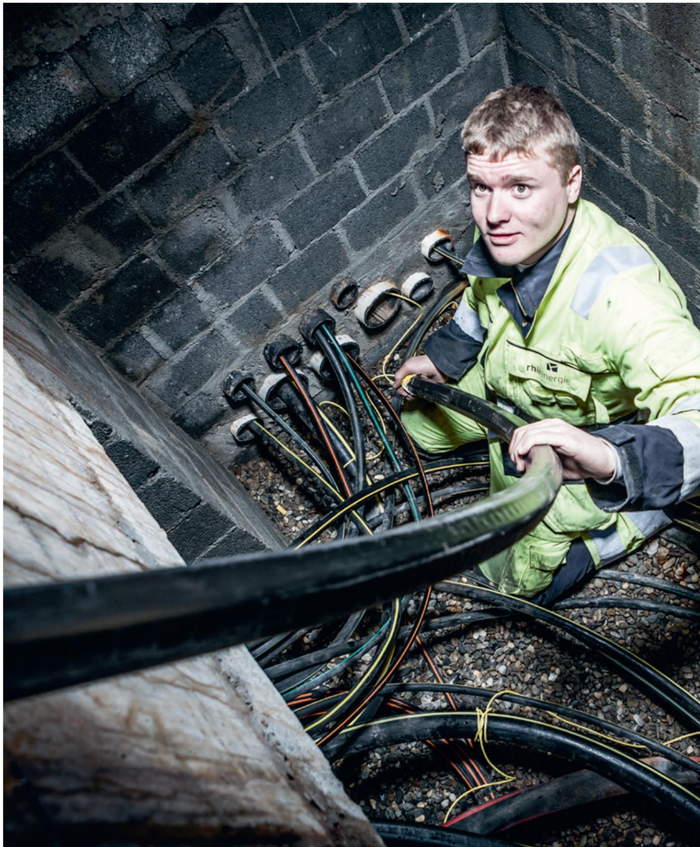
Lernender Netzelektriker Manuel Bucheli beim Einzug eines Speed Pipe Rohrverbundes für einen schnellen Glasfaseranschluss.
