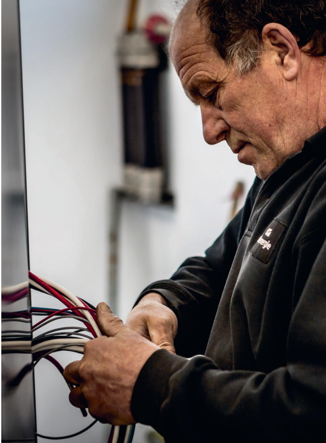
Gruppenchef Peter Schneller verdrahtet den Zähler für die öffentliche Beleuchtung in einer neuen Niederspannungsverteilung einer Transformatorenstation.
